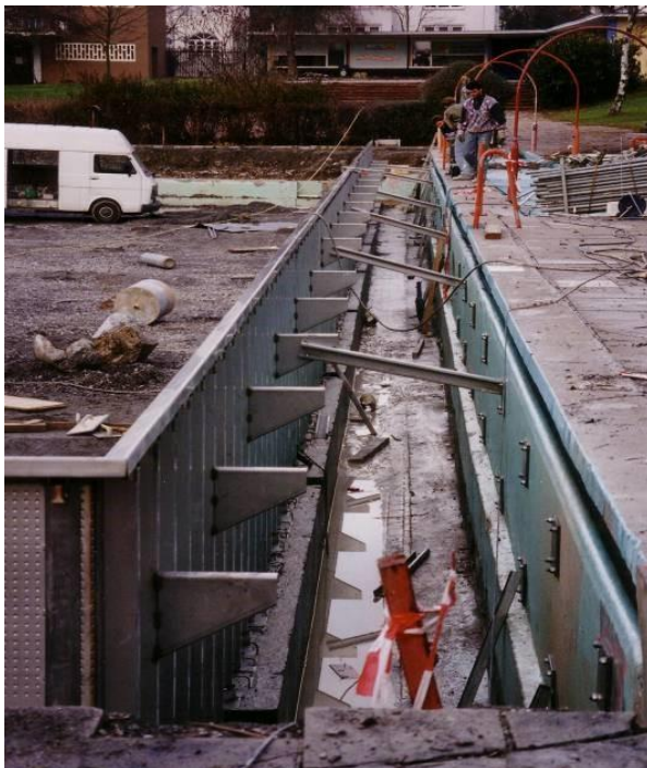
Figure 8 - Parois auto-portante dans l'existant
