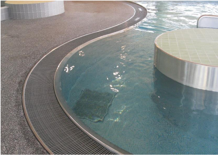
Figure 15 - Goulotte de débordement en affleurement de la plage
