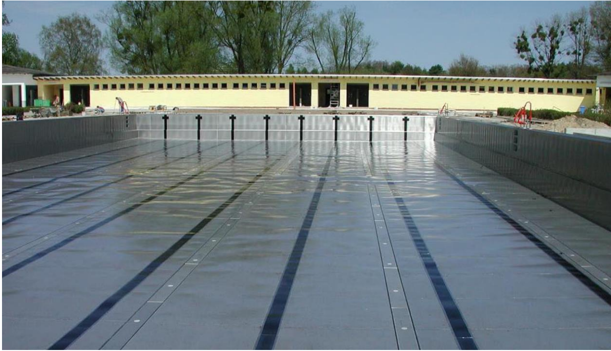
Figure 13 - Photo d'un exemple de fond de bassin lisse présentant un marquage des couloirs de natation
